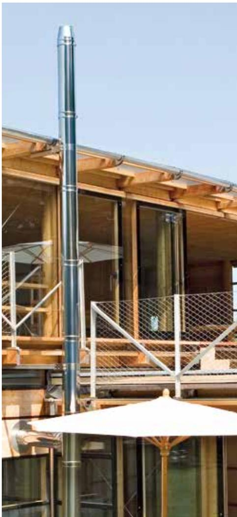
**KERASTAR** ist ein Edelstahlsystem in Elementbauweise, das sich schnell und einfach versetzen lässt. Die keramischen Profil-Innenrohre besitzen eine keramische Steckverbindung, die mit genau abgestimmter Fugenmasse die Stoßverbindungen sichert. Den erforderlichen Wärmeschutz gewährleistet eine durchgehende, 60 mm dicke Mineralfaser-Dämmschicht. Am Edelstahl-Außenrohr sichern integrierte Klemmbänder mit Spannverschlüssen die Elementverbindungen.
